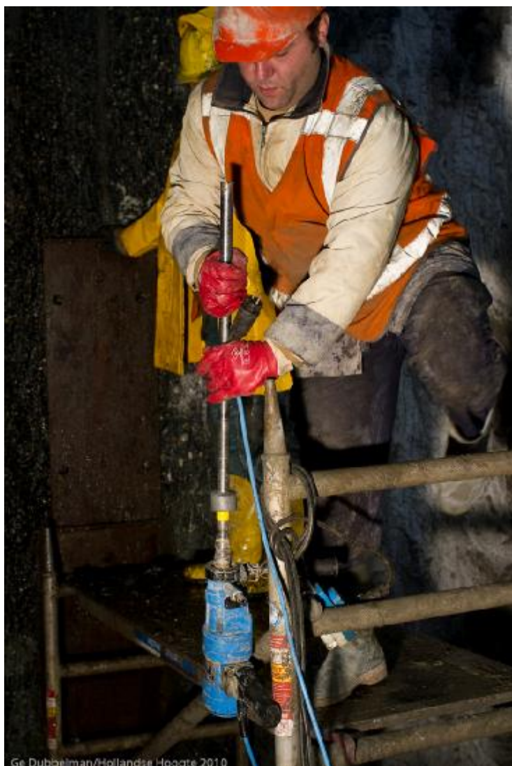
Werkzaamheden in station Rokin
