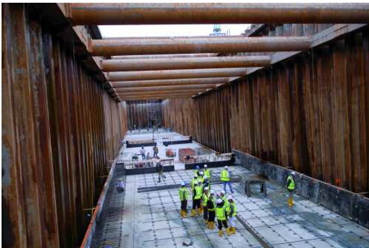
De open bouwput op het Europaplein.
