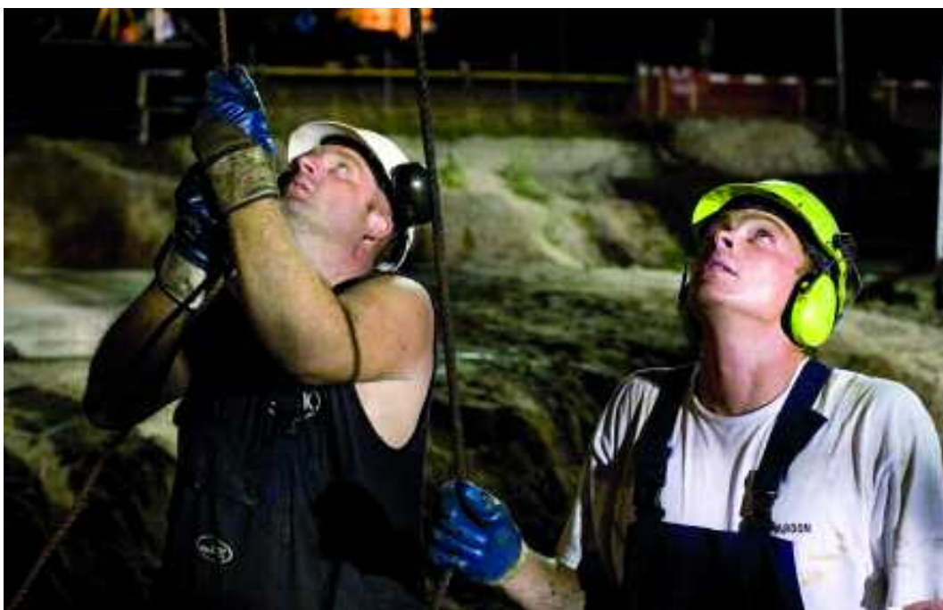
Geconcentreerde aandacht voor het heikwerk naast de Ring A10-zuid.
