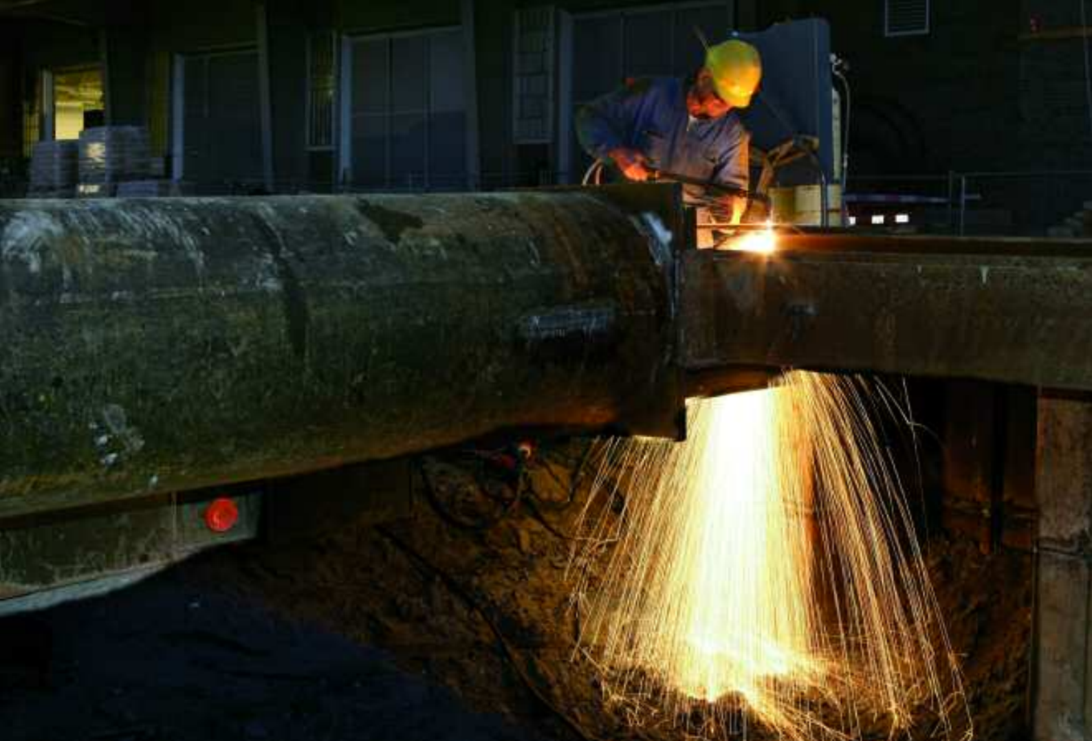
Het aanbrengen van de stempels in de bouwkuip voor de zuidelijke tunnelbak.
