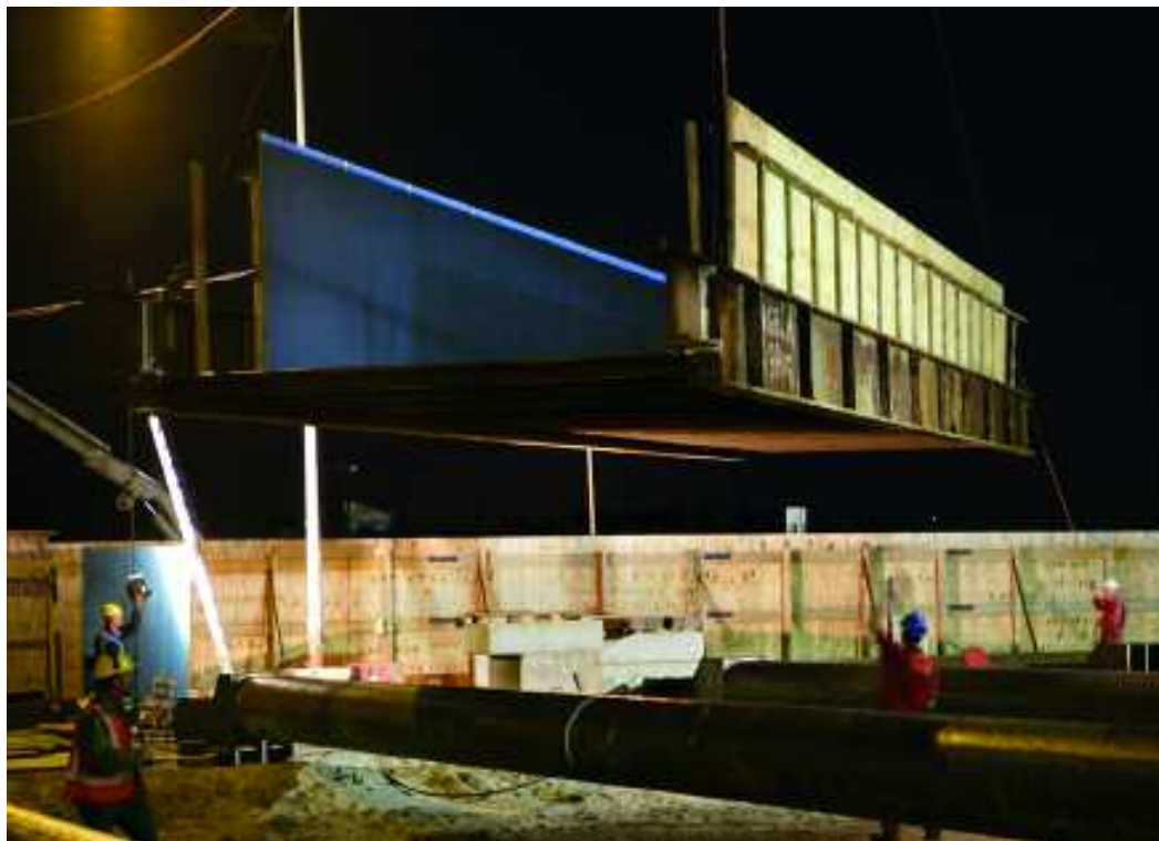
Het plaatsen van de hulpbruggen over de bouwkuip voor de westelijke reizigerscorridor.
