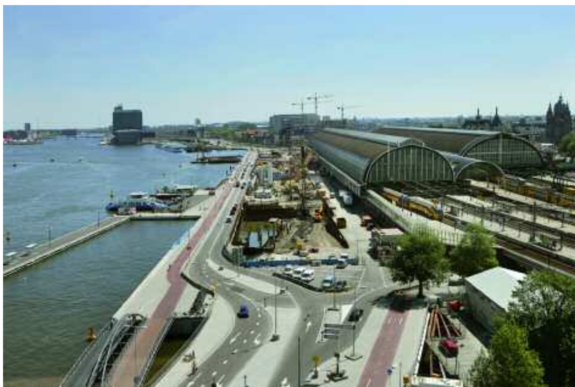
De bouwplaats voor de autotunnel onder de De Ruijterkade achter het Centraal Station.
