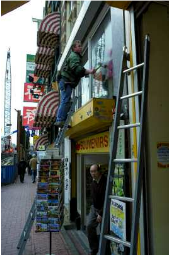
Het regelmatig lappen van de ramen is een van de maatregelen om de omgeving van de bouwplaatsen schoon en leefbaar te houden. Hier is de glazenwasser bezig op het Rokin.
