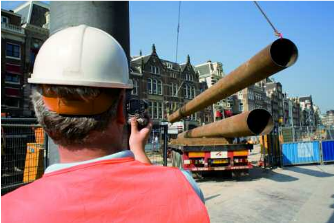
Tot eind september werd op het Rokin gewerkt aan het dak en de wanden van de zuidelijke toegangshal. De stalen stutbalken worden hier verwijderd. Uitvoerder Klaus Leuffen van aannemer Max Bögl fotografeert het transport.
