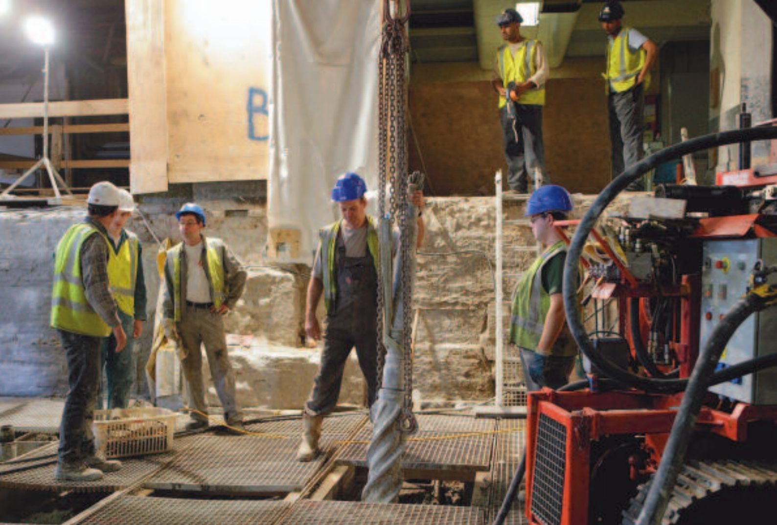
Een blik achter de bouwhekken in de centrale hal van het station. Bouwvakkers werken aan een nieuwe fundering onder het stationsgebouw.
