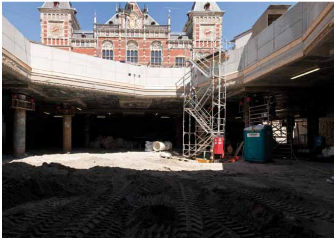
De diepe put op het voorplein van Amsterdam CS: Het nieuwe metrostation werd dit kwartaal uitgegraven tot NAP -3,8 meter.
