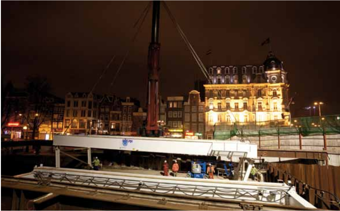
Begin april werden twee portaalkranen op de rails boven de bouwkuip van de startschacht geplaatst. Dit verliep voorspoedig en kon in één avond en nacht worden afgerond.
