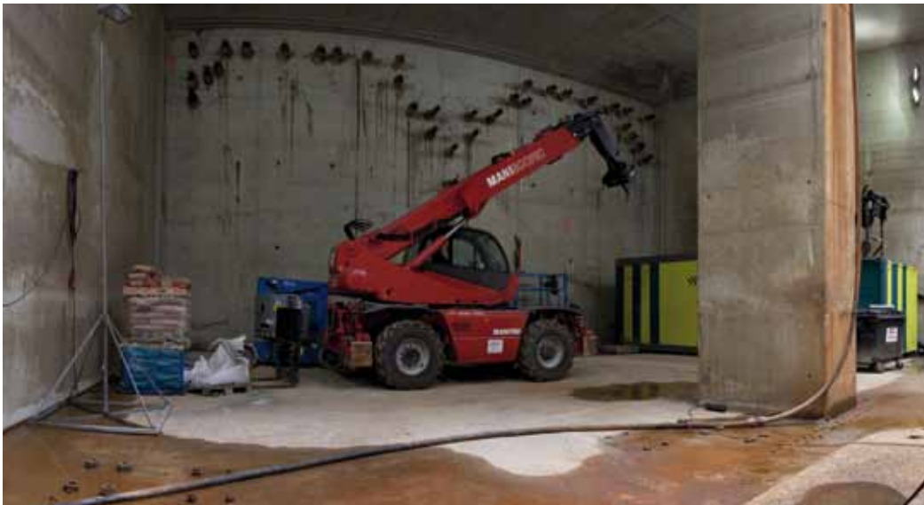
Startschacht in het Natte Damrak van waaruit de tunnelboormachines zullen vertrekken in het voorjaar van 2010. In de wand zitten vrieslansen waarmee een vriesschild onder het Natte Damrak zal worden gecreëerd.
