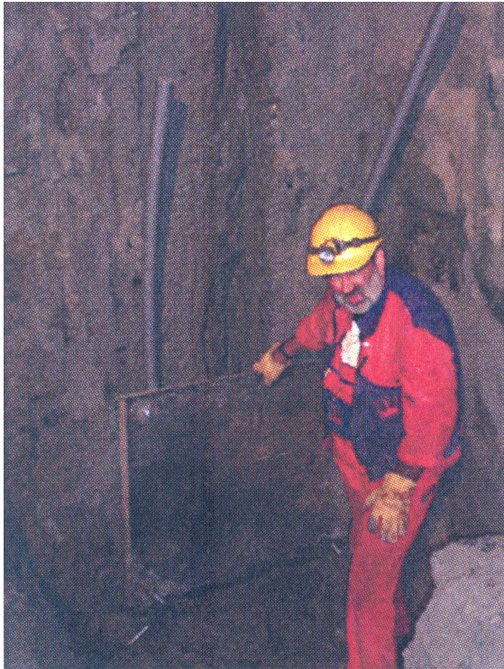
Illustratie 2 de bewuste plek vlak voor de doorbraak (foto Max Bogl). De donkere plek is de bentonietinsluiting.
