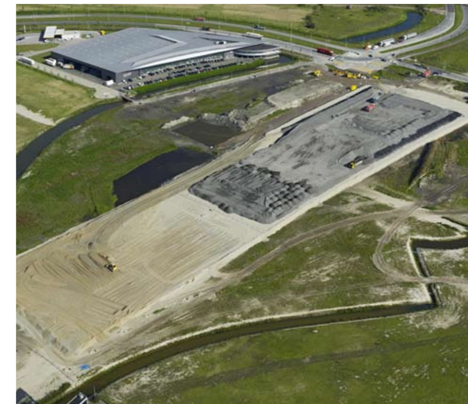
Aanbrengen zand en AVI-bodemassas
