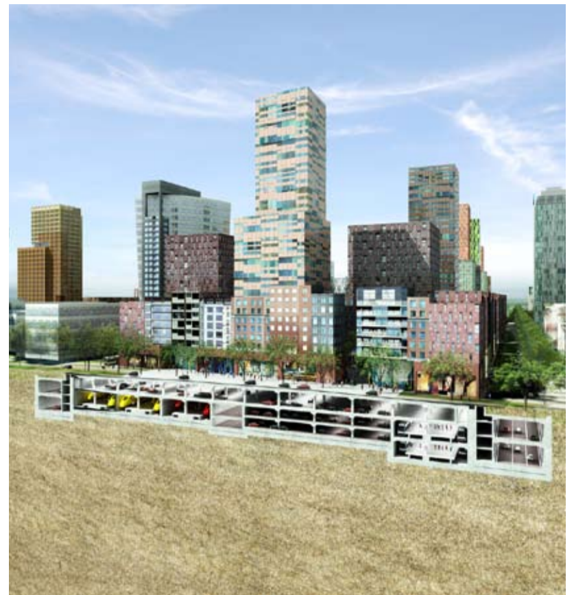
Doorsnede tunnels Dokzone Zuidas. Bij de Zuidas komen de tunnels qua tunnelveiligheid in elkaars invloedssfeer. Daarom is een integrale benadering van veiligheid nodig.
