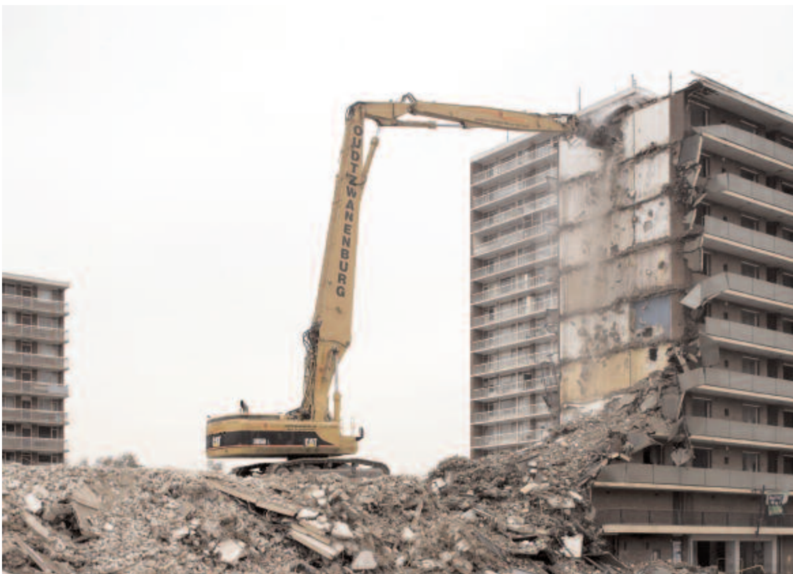
Flatgebouw Beverwijkstraat is gesloopt met behulp van een hydraulische knipper.
