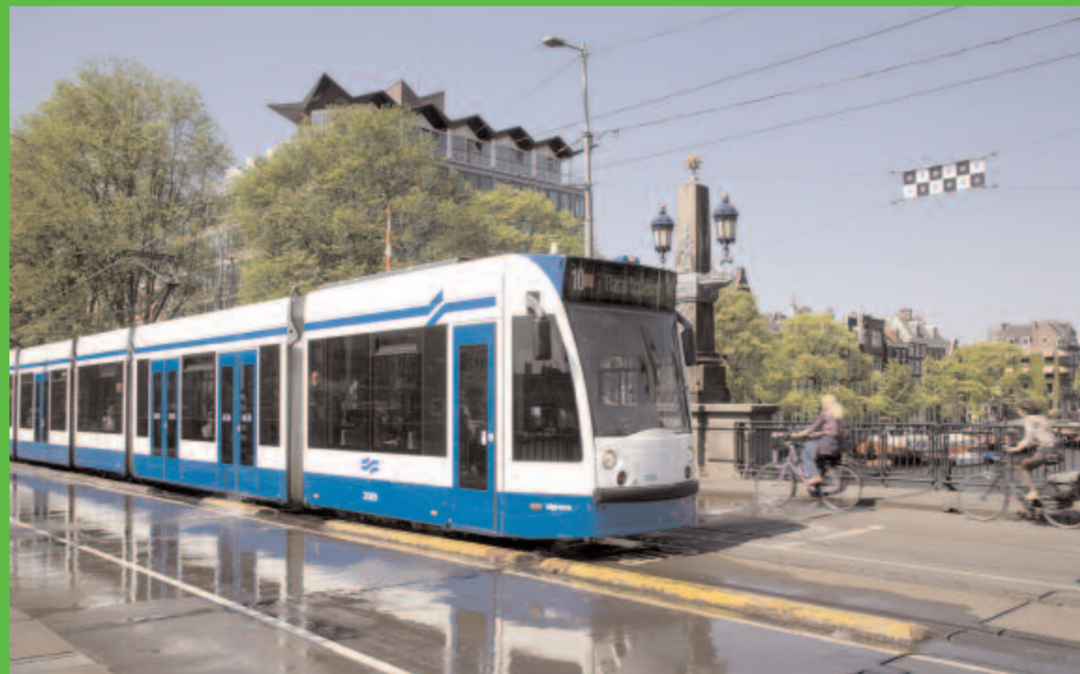
Water op de brug Hoge Sluis ter beperking van de temperatuuruitzetting.
