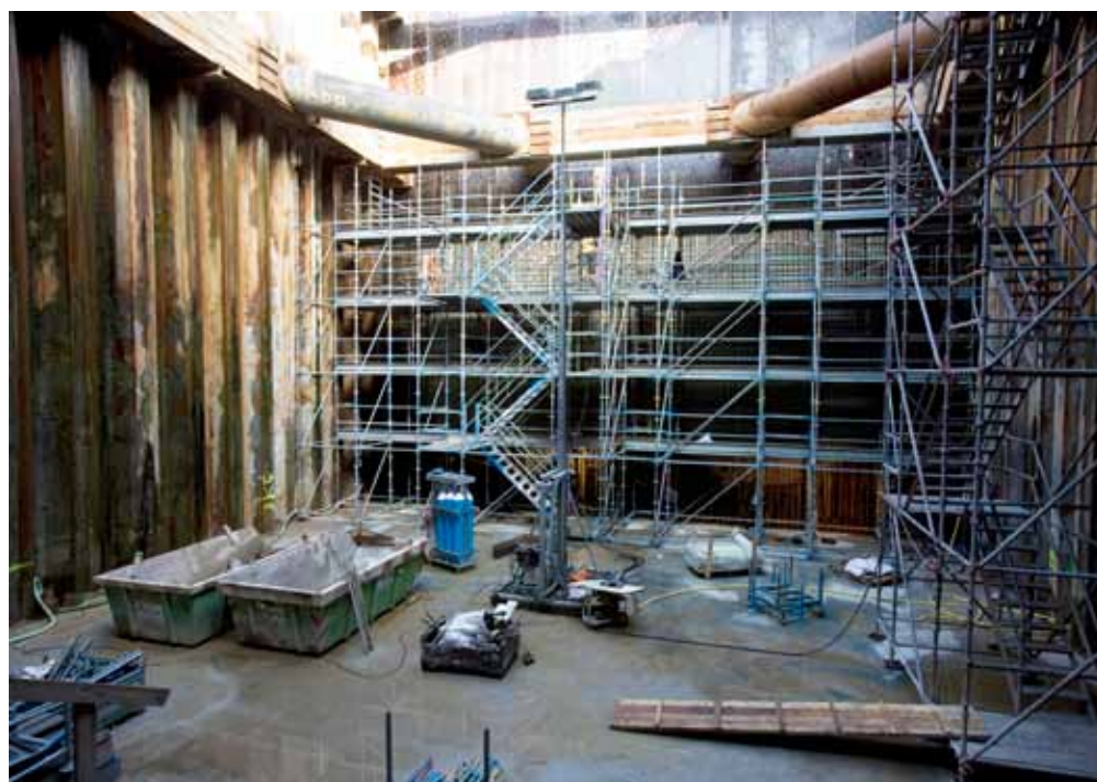
DE EINDSCHACHT VAN DE BOORMACHINES WORDT NU OOK EEN STARTSCHACHT
